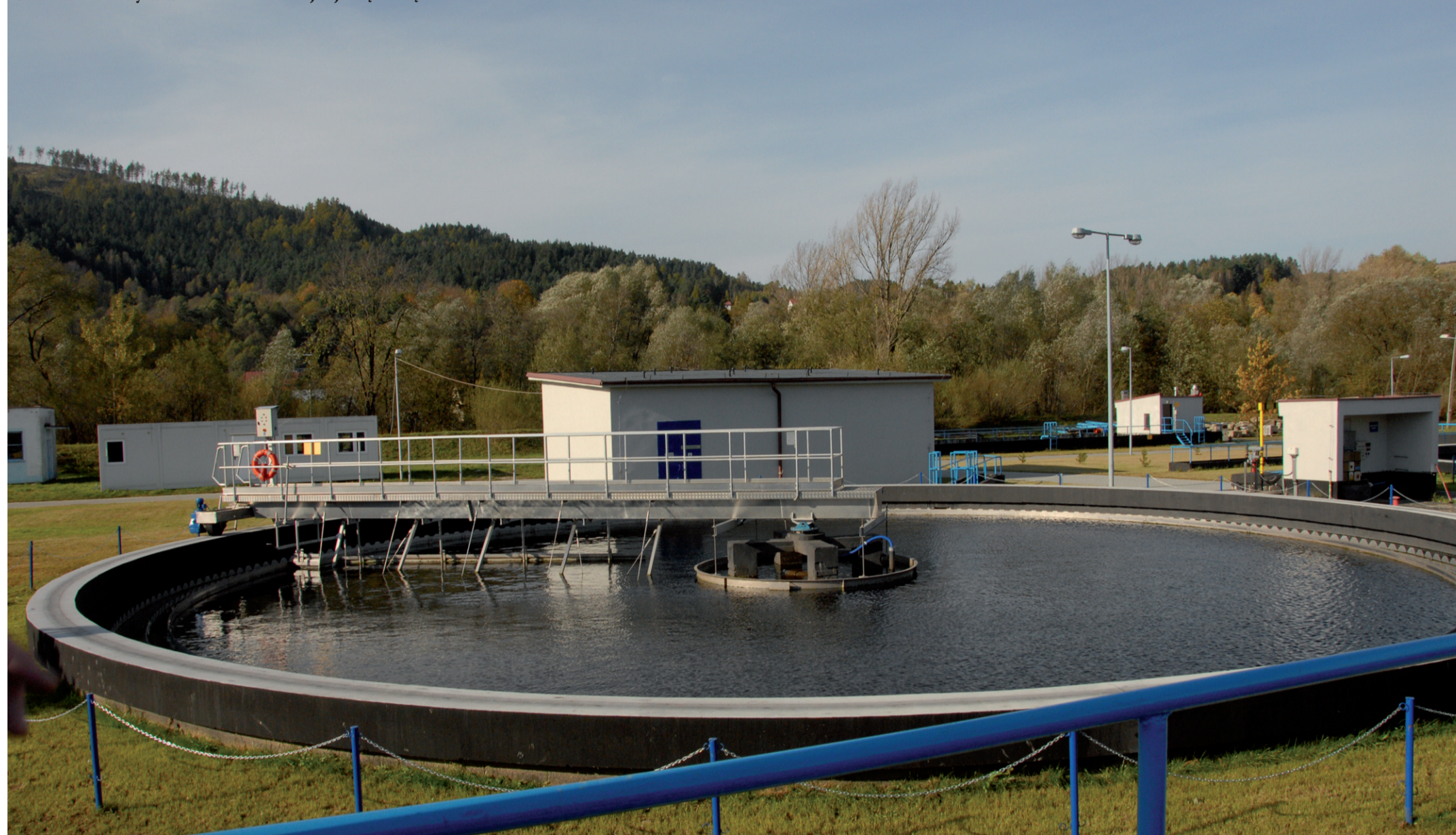
Nowoczesna oczyszczalnia ścieków znajduje się w Cięcinie
